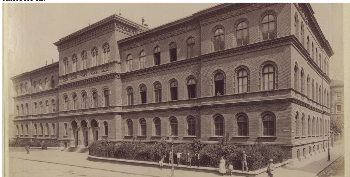
A Markó utca 19-21. sz. alatti épület
